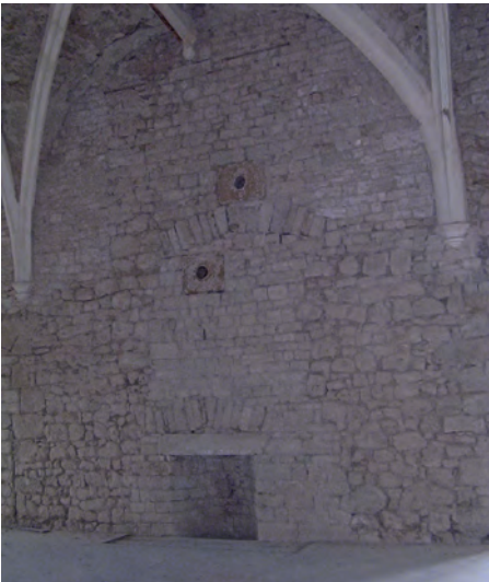
Afb. 13 – Derde verdieping van de donjon van Schoenfels (Foto R. Schaus, augustus 2003).
