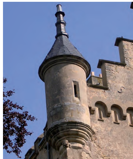
ILL. 7 – Photo d'une des tourelles d'angle (Photo R. Schaus, janvier 2015).
