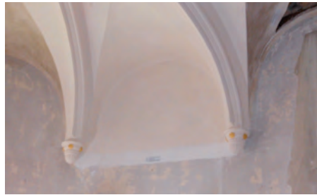
ILL. 14 – Partie rénovée du plafond au rez-de-chaussée (Photo P. Schaul, octobre 2014).
