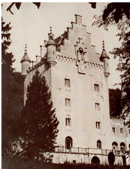
ILL. 5 – Photo ancienne du château.
